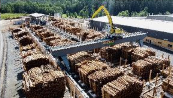
Bild 1: GELO Timber hat in Wunsiedel im Fichtelgebirge das weltweit modernste Schwachholzsägewerk errichtet.
